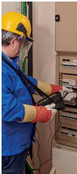
Contrôle d'une armoire électrique
