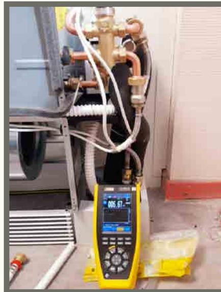
Mesure sur système de chauffage et climatisation : courant, tension, température.
